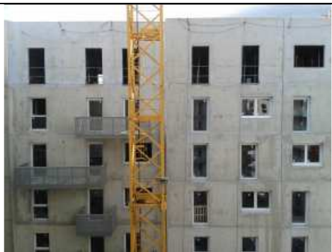
Photo 5 : vue sur les balcons déjà posés, et de l'ensemble des jeux de cordes mis en place.
