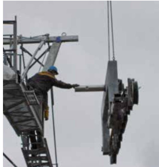
Le guidage prématuré de la charge à la main est une prise de risque inutile. Sur cette situation, la charge est encore en approche. Il faut laisser le pilote amener le colis au plus près de l'endroit prévu. L'opérateur au sol ne le guide qu'au dernier moment pour réduire les risques d'écrasement liés au mouvement de la charge.
