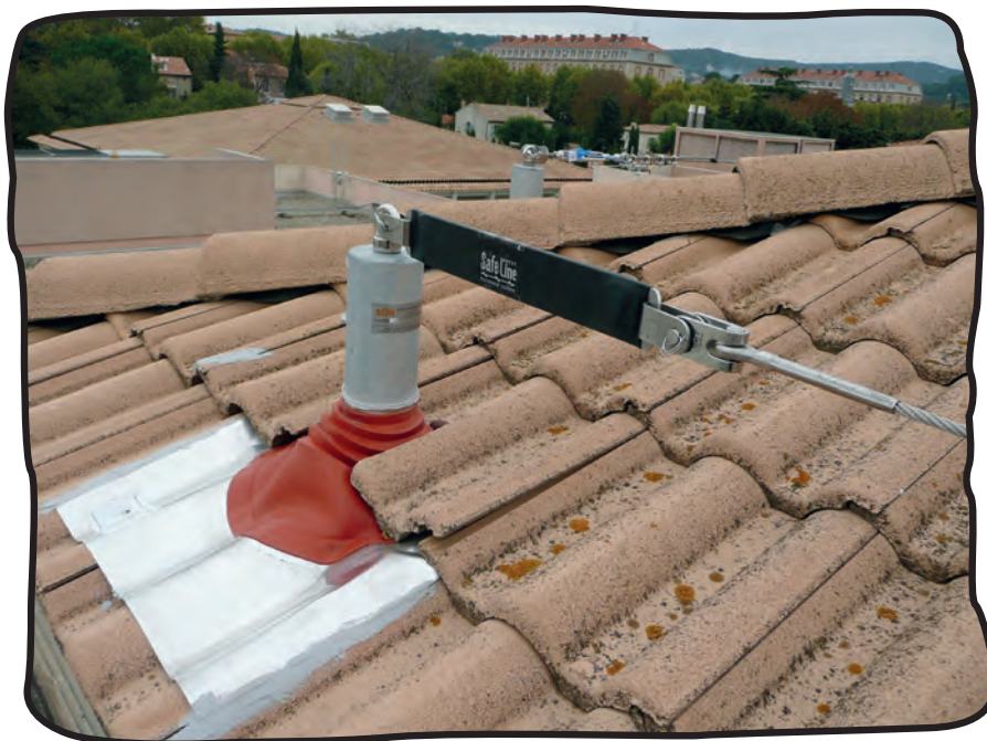
Exemple d'ancre structurelle terminale.
