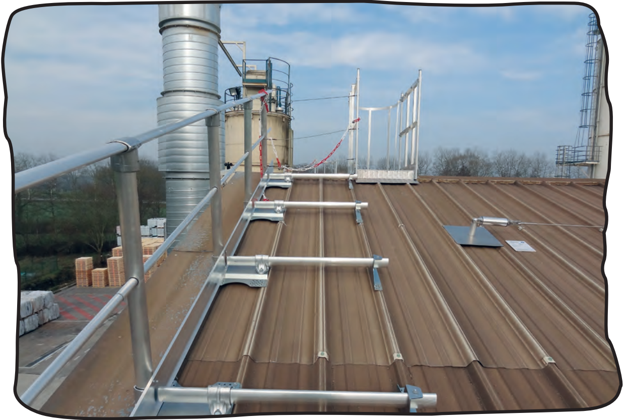
Exemple d'accès avec protection par garde-corps.
