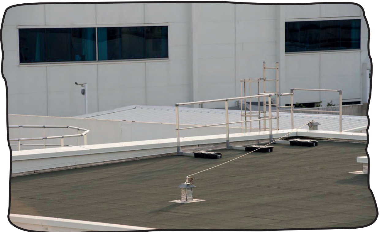
Exemple d'accès avec protection par garde-corps.
