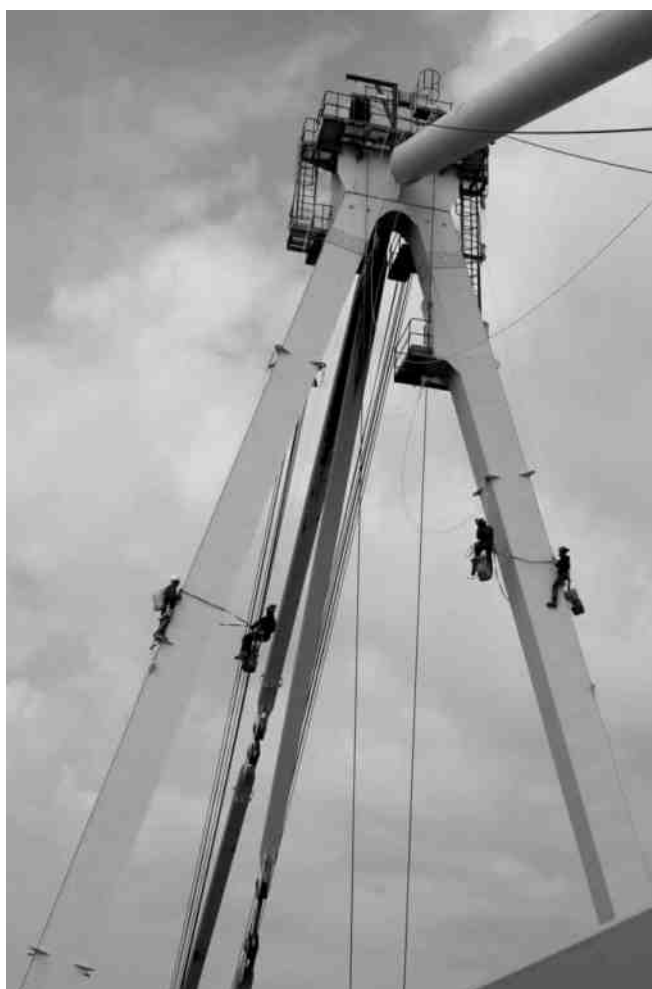
À chaque assemblée générale, les cordistes révisent les techniques de sauvetage sur cordes. Dispersés entre les chantiers, les sous-traitants et les boîtes d'intérim, ils n'ont pas souvent l'occasion de le faire sur leur temps de travail. Photo éva d'Annunzio
